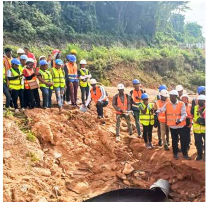
Le site dédié aux matériaux d'emprunt est connu. Il est situé à 6,5 km du projet, plus précisément au Lycée Technique de Foréké-Dschang. Une fois les enrochements terminés et le dalot posé, l'étape de remblaiement sera engagée. La structure de chaussée arrêtée est constituée en couche de fondation/base (concassé 0/31,5) suivie du revêtement en la couche de roulement en béton bitumineux.
